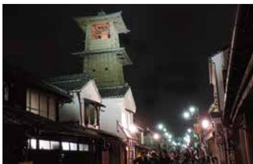
●時の鐘耐震化工事の実施
