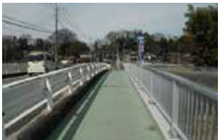
●田島橋歩道橋整備(笠幡西部)
