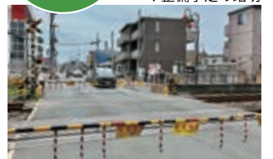
▼県道川越線越生線右折帯整備(完了)
