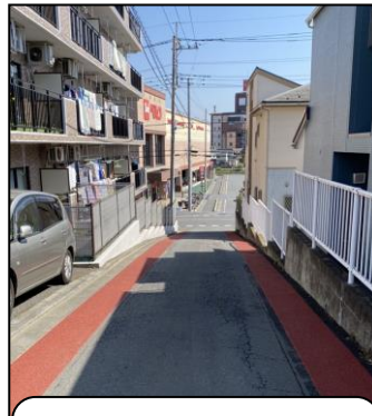
小仙波3・4丁目ベルク付近 道路滑り止め整備完了
